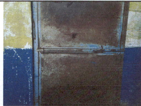
Foto 6: Sustitución de puerta de baño
