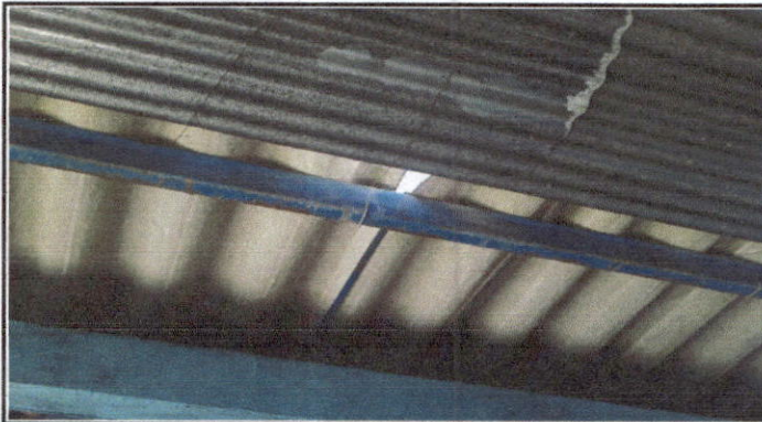
Foto 3: Sustitución de canales
